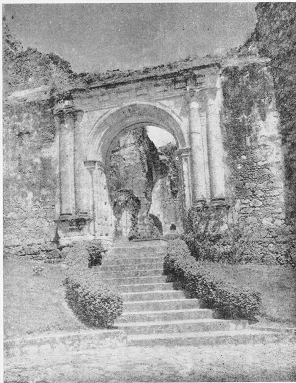
RUINAS DEL PRIMER CONVENTO FRANCISCANO CONSTRUIDO EN EL CONTINENTE AMERICANO
