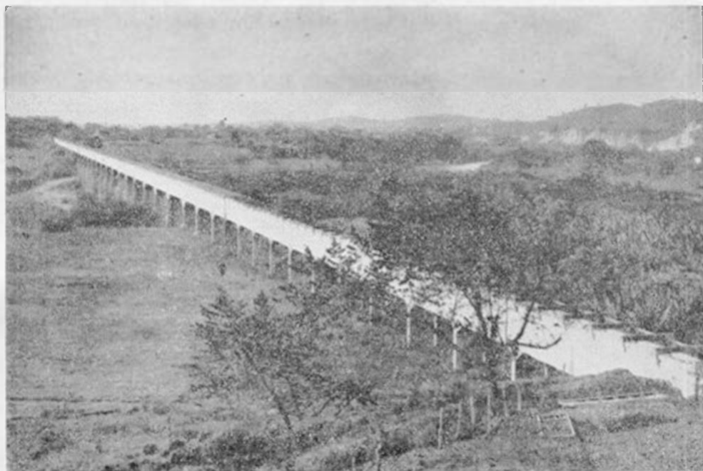
"FLUME" DE 750 METROS QUE LLEVA UNO DE LOS PRINCIPALES CANALES DE RIEGO POR ENCIMA DE UN VALLE
