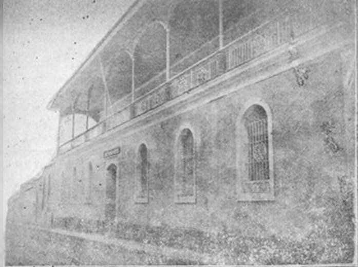
Fachada del Seminario después de los trabajos restauración por Mons. Nouel. La galería fue destruida en 1930.
