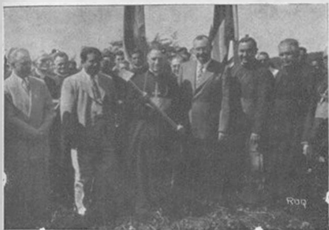
Histórico momento en que el Excmo. Representante del Santo Padre Mons. ALFREDO PACINI, da el primer picazo para comenzar las obras del nuevo Seminario. 17 de febrero de 1947.
