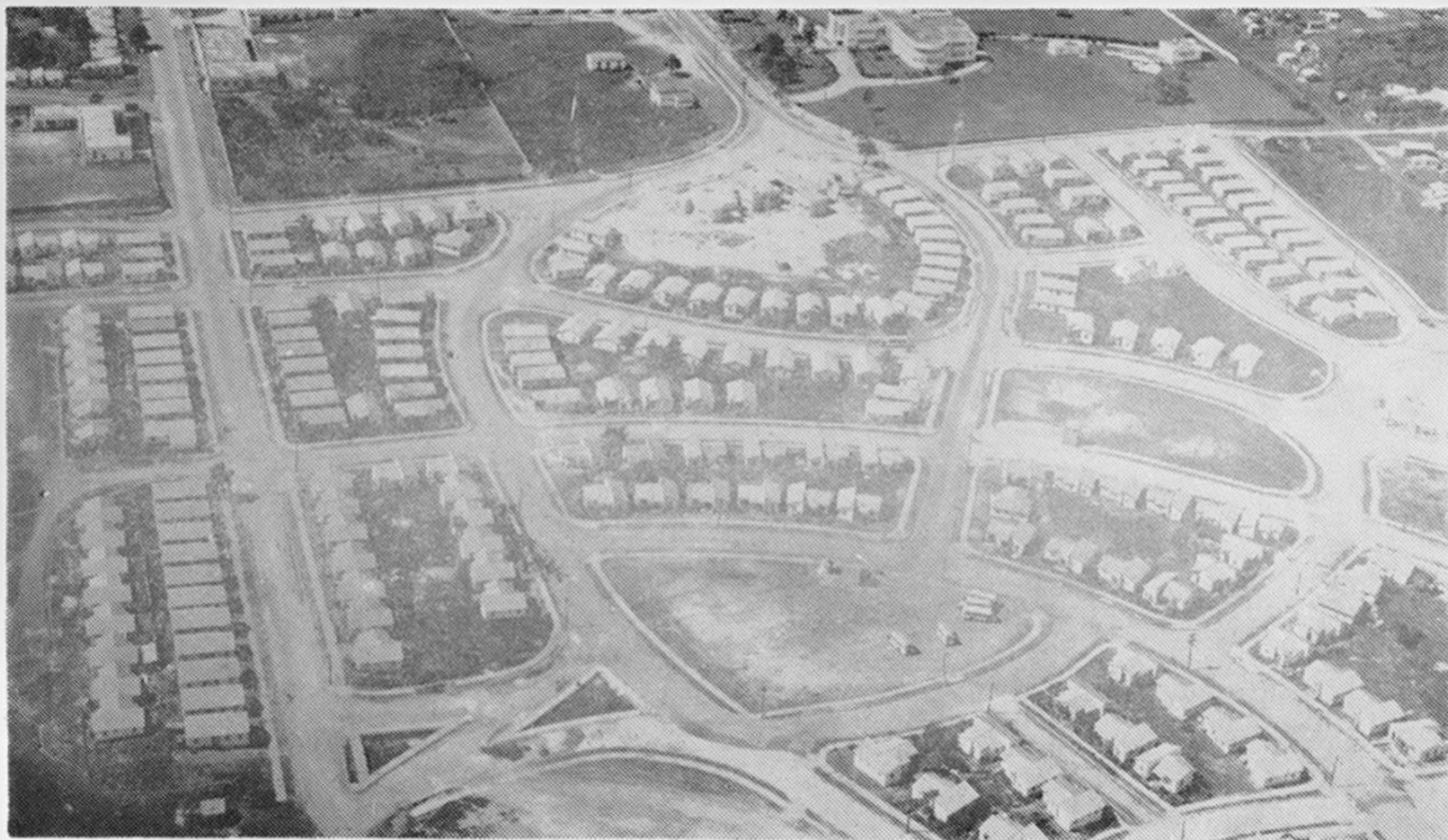
Vista aérea de un sector del barrio de María Auxiliadora, Ciudad Trujillo, construido de acuerdo con las exigencias de estos últimos tiempos.
