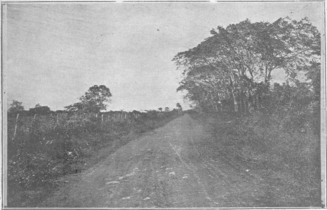
Camino de "Santa Cruz" que conduce al sitio de la barca del mismo nombre, sobre el río Isabela .
