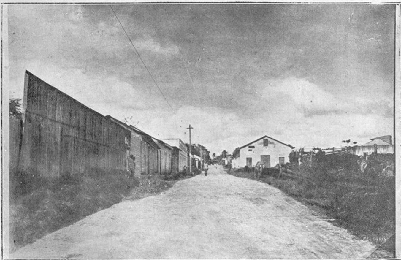
Calle "Emilio Prud'Home" modernizada en el año de 1920.
