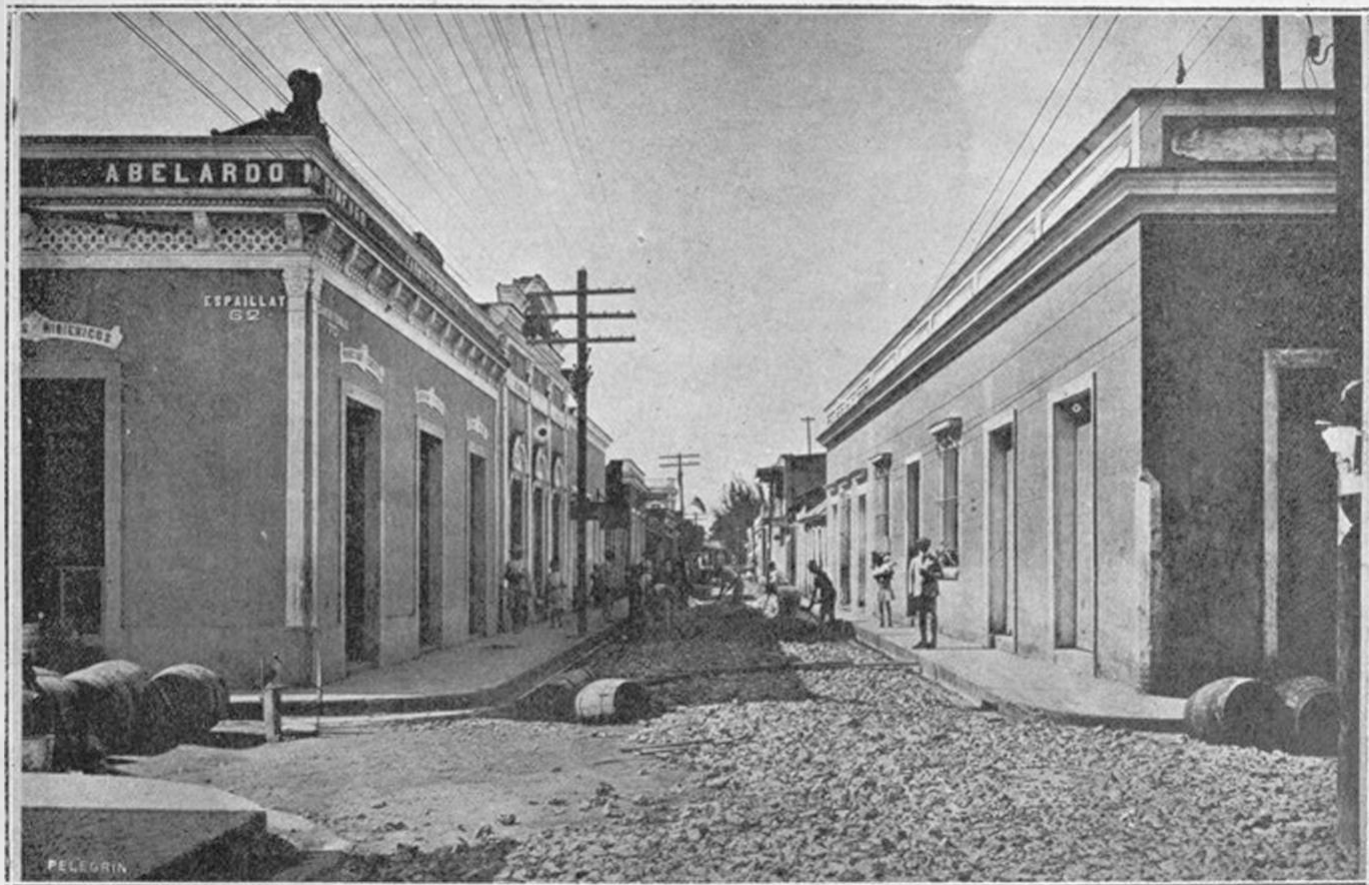
CALLE "SANTO TOMAS" — Preparación del pavimento por el sistema "Macadam Tarvia".
