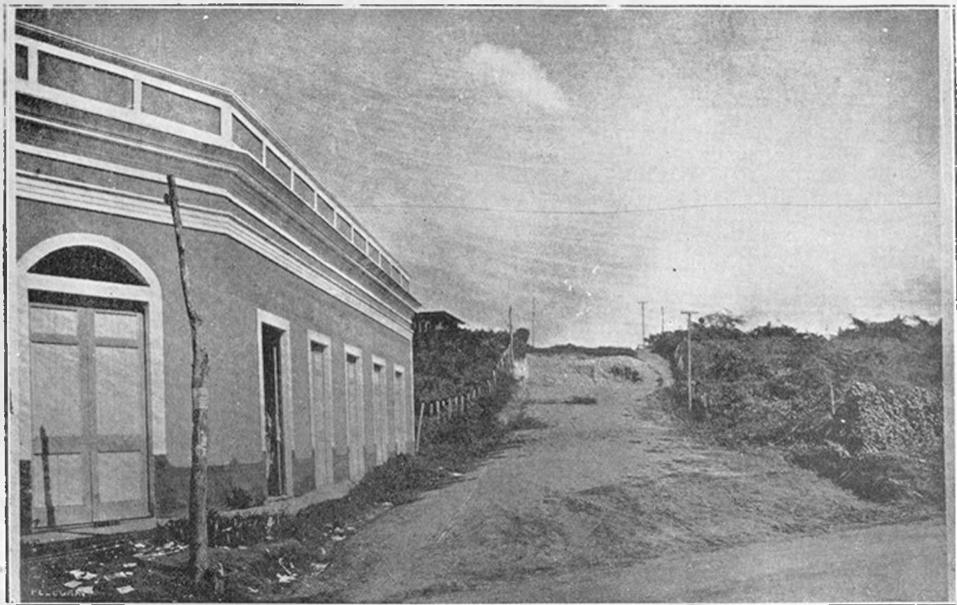
Calle "Mr. Marie", en la cual se procede á la demolición de una cuesta que permitirá el acceso entre la "Avenida de Mayo" y la calle "Real".
