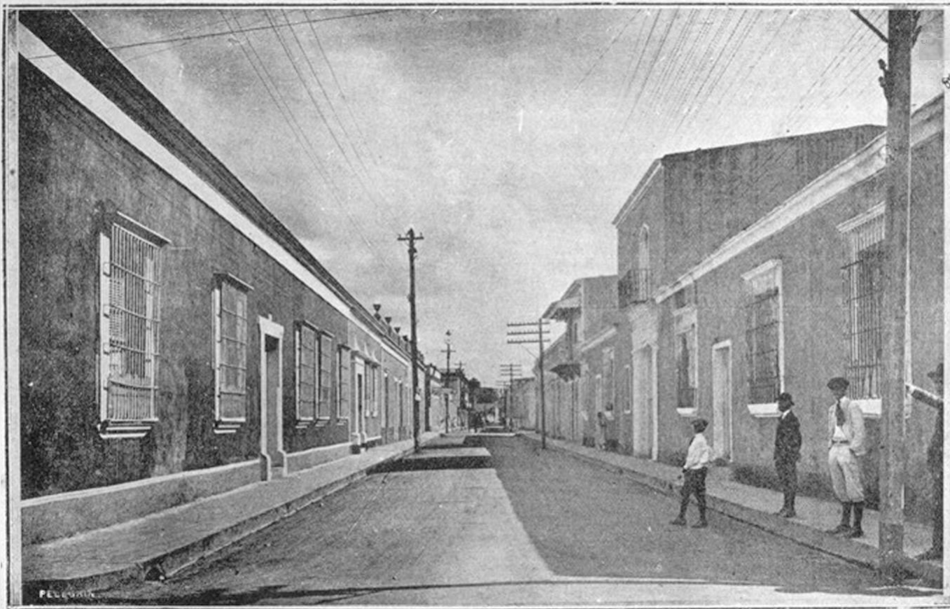
CALLE "SANTO TOMAS" — Un tramo terminado.
