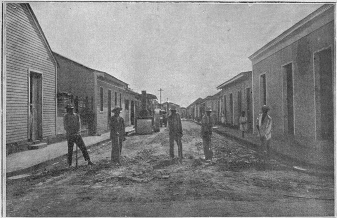
Peones del Municipio sorprendidos en sus trabajos de arreglo de la calle "Palo Hincado".
